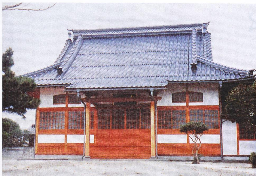
長徳寺本堂改築工事
