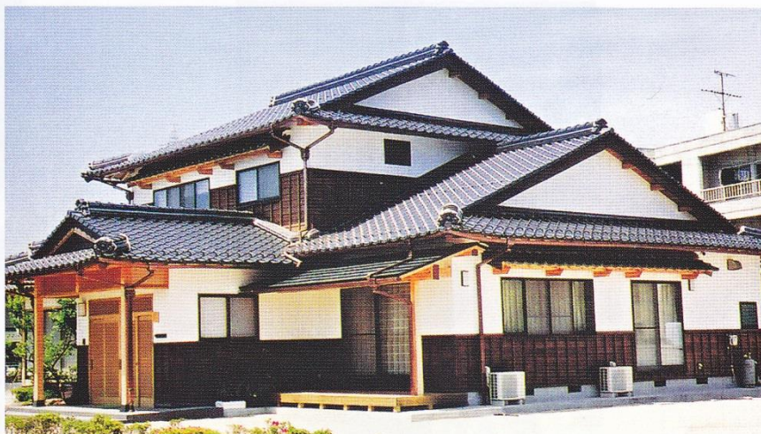
A邸新築工事
