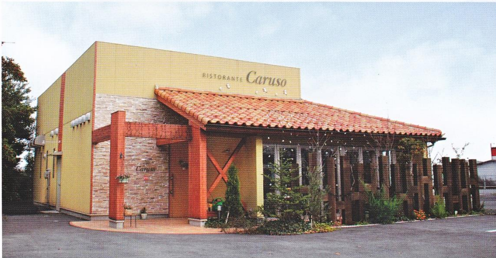
レストラン カルーソ新築工事
