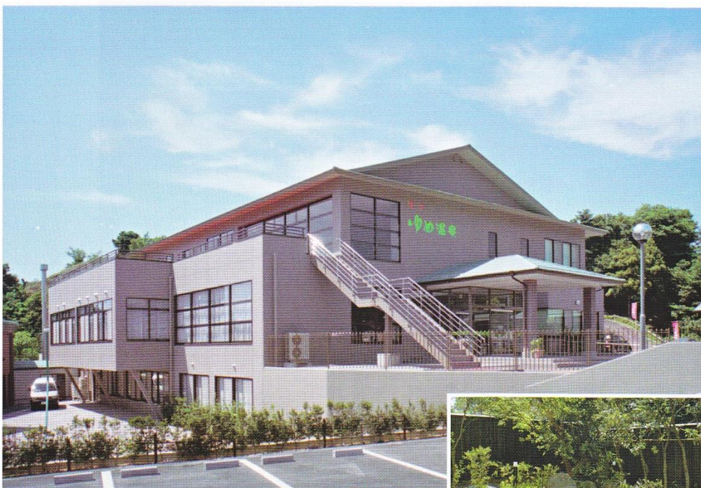
淀江ゆめ温泉(淀江町温浴施設 新築工事)
