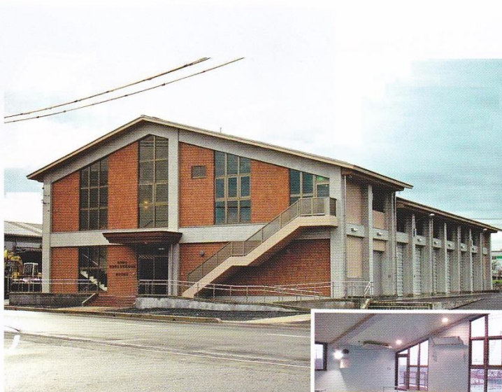
県立境港総合技術高等学校 海洋実習棟新築工事(建築)
