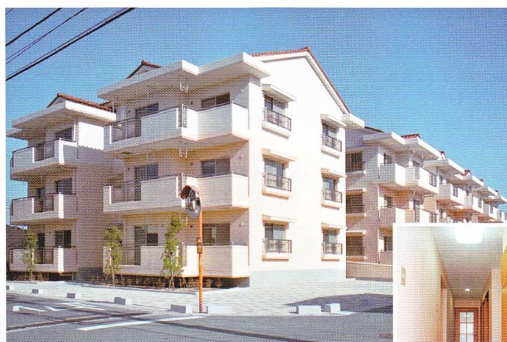
米子警察署両三柳職員宿舍 新築工事(建築)
